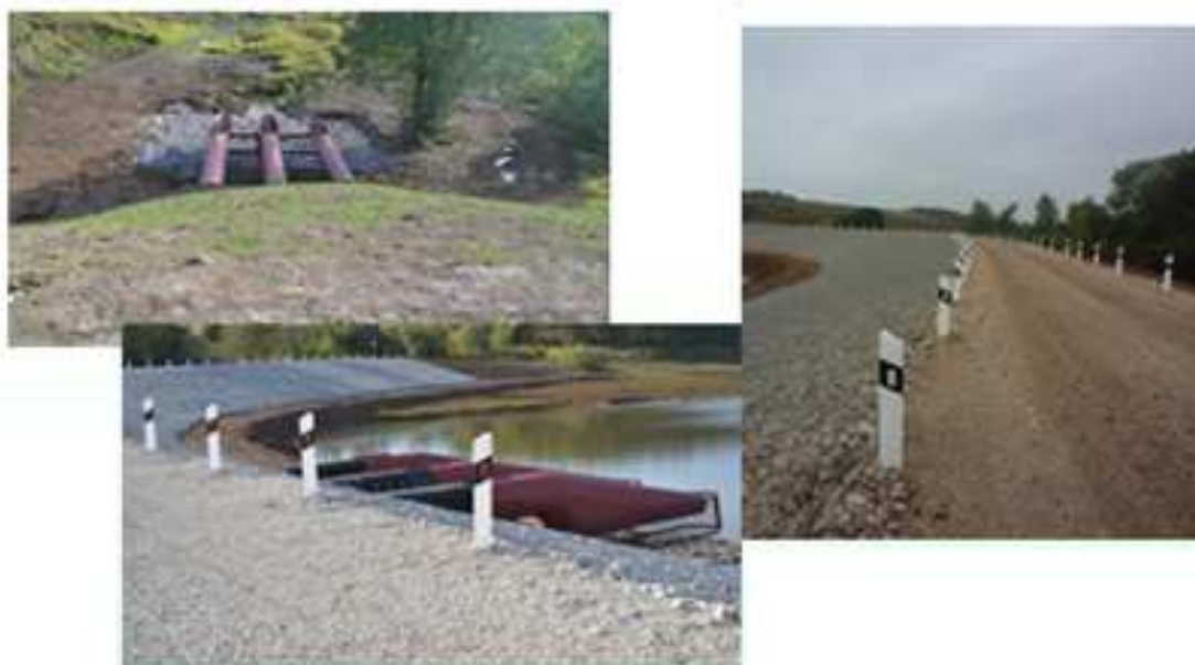
Рис.6. Гидротехнического сооружения пруда на р. Тулица вблизи д. Федяшево Ясногорского района (после капитального ремонта)
