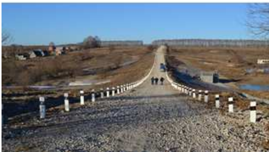
Рис.5. гидротехнического сооружения пруда в н.п. БизюкиноАлексинского района (после капитального ремонта)
