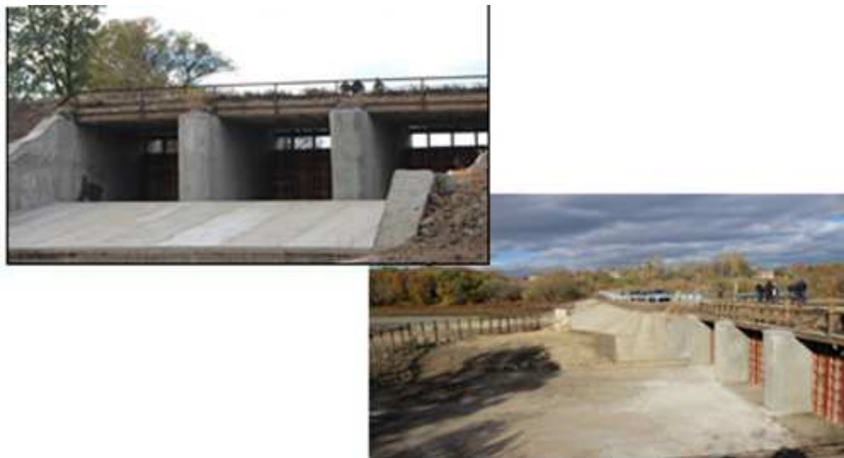
Рис.4. гидротехнического сооружения на р. Непрядва вблизи д. Пруды Воловского района (после капитального ремонта)
